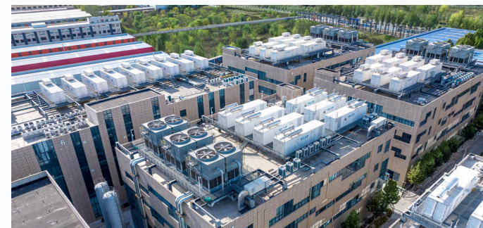
三河铭泰绿色数据中心鸟瞰图 Aerial view of Sanhe Mingtai Green Data Center
